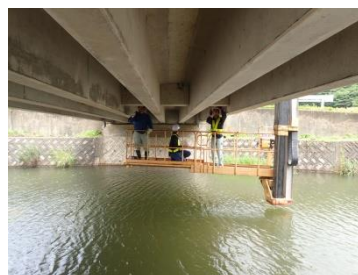
定期点検状況
