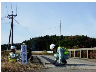
定期点検状況
