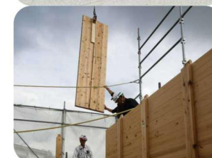
西日本豪雨災害復興公営住宅
