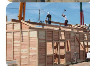
東日本大震災仮設住宅
