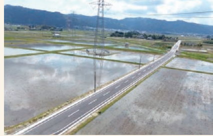
町道 T-265 号線改良工事 (新庄地内)
