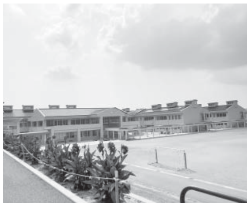
堰堤に守られる鹿島小学校
