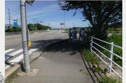
二宮地内 二宮交差点 ガードレールが無い
