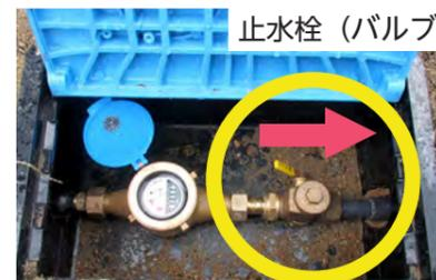
止水栓（バルブ） 黄色のレバーを矢印の方向に倒すと止水栓（バルブ）が閉まります。
