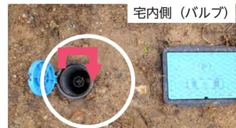
宅内側（バルブ）メーターボックスより宅内側に止水栓（バルブ）が設置されているお宅は、矢印の方向に回すと止水栓（バルブ）が閉まります。
