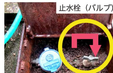
止水栓（バルブ） 矢印の方向に回すと止水栓（バルブ）が閉まります。
