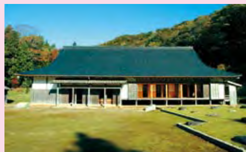
復元された大宮坊「書院台所棟」全景
