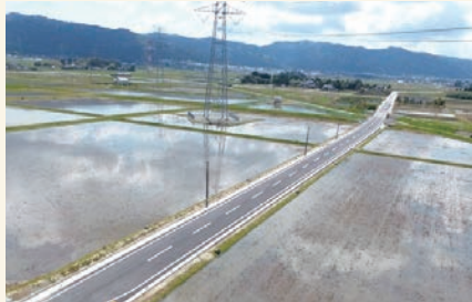
町道 T-265 号線改良工事（新庄地内）
