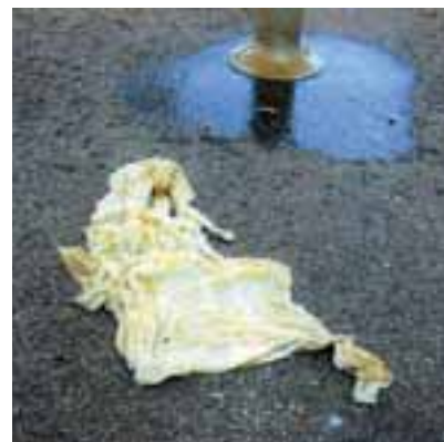
実際にポンプに詰まっていたモノです
