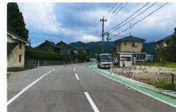
町道K1-6号線（坪川地内）
